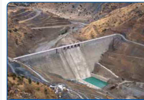
Şırnak Silopi Barajı
