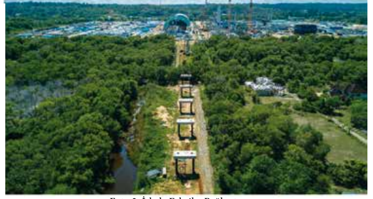
Foto 2: İskele Fabrika Bağlantısı
