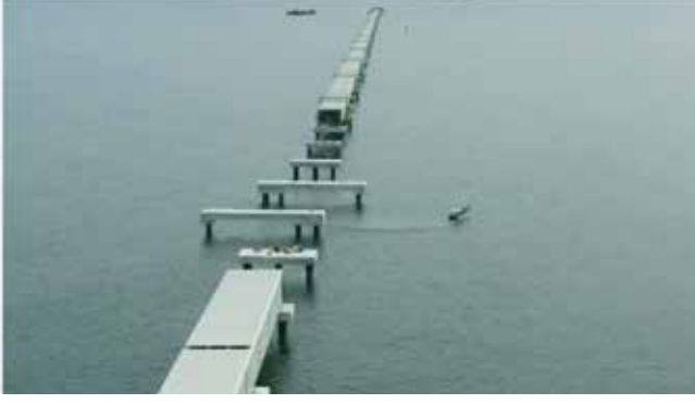
Foto 3: Yaklaşım İskelesi Metanol Hattı Geçişi
